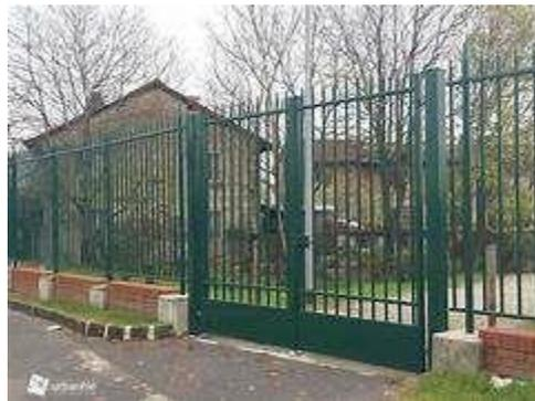
Sistema in ferro battuto o zincato da tenere in considerazione nei casi in cui è necessario puntare sull'aspetto estetico oltre che su quello strettamente funzionale di confinamento delle aree verdi. Estremamente solide e stabili, sono perfette in un contesto urbano. Nello specifico del progetto verranno realizzate solo dove già esistenti per la sostituzione di parti ammalorate.
