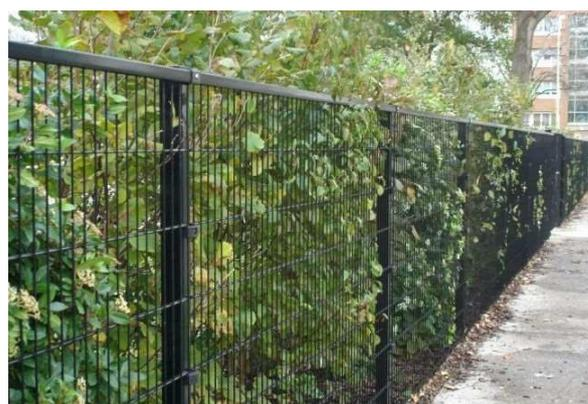
Sistema completo composto da pannelli di rete elettrosaldata a maglia rettangolare di dimensioni 200×50 mm, formate da piatti orizzontali 15×6 mm e da fili verticali di diametro 5 mm. I pannelli, di larghezza massima 2500 mm, sono da installare in altezze variabili da 630 mm a 2030 mm in base all'esigenza specifica e devono essere dotati di corrente orizzontale superiore di rinforzo per garantire una maggiore robustezza.
