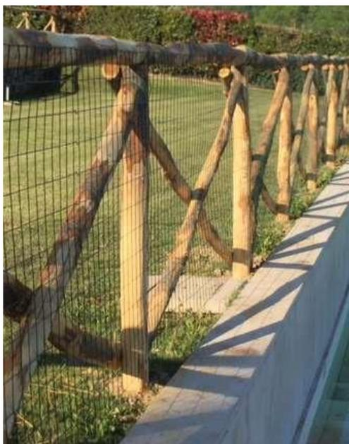
Sistema con moduli costituenti la recinzione realizzati interamente in legno con pali in pino nordico tornito e impregnato in autoclave in classe 4 con sali preservanti a base di rame, in conformità alle norme DIN 68800. Ogni modulo generalmente è costituito da:
